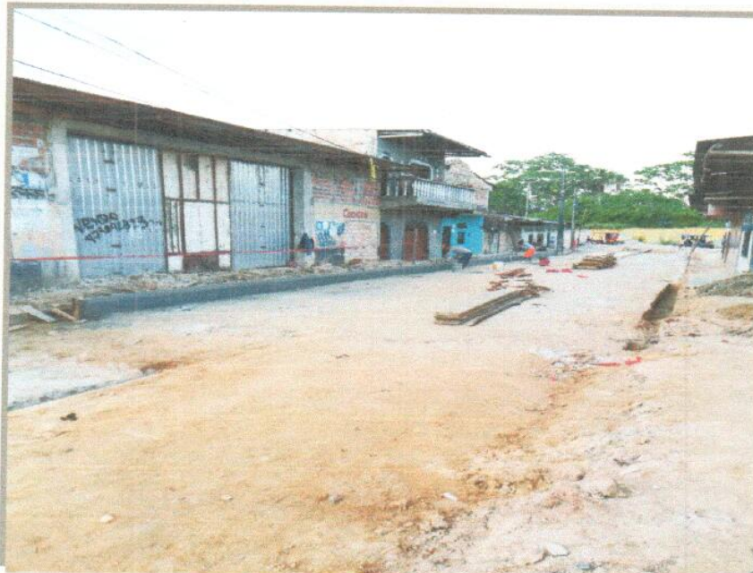
VISTA FOTOGRÁFICA N° 02 – VACEADO DE SARDINEL Y CONFORMACION DE A-2-4 EN CALLE LAGUNAS
