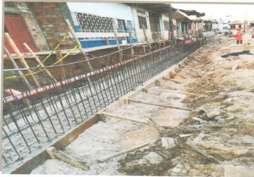
VISTA FOTOGRÁFICA N° 01 – VACEADO DE LOSA DE FONDO CANAL PSJ. CASTAÑA
