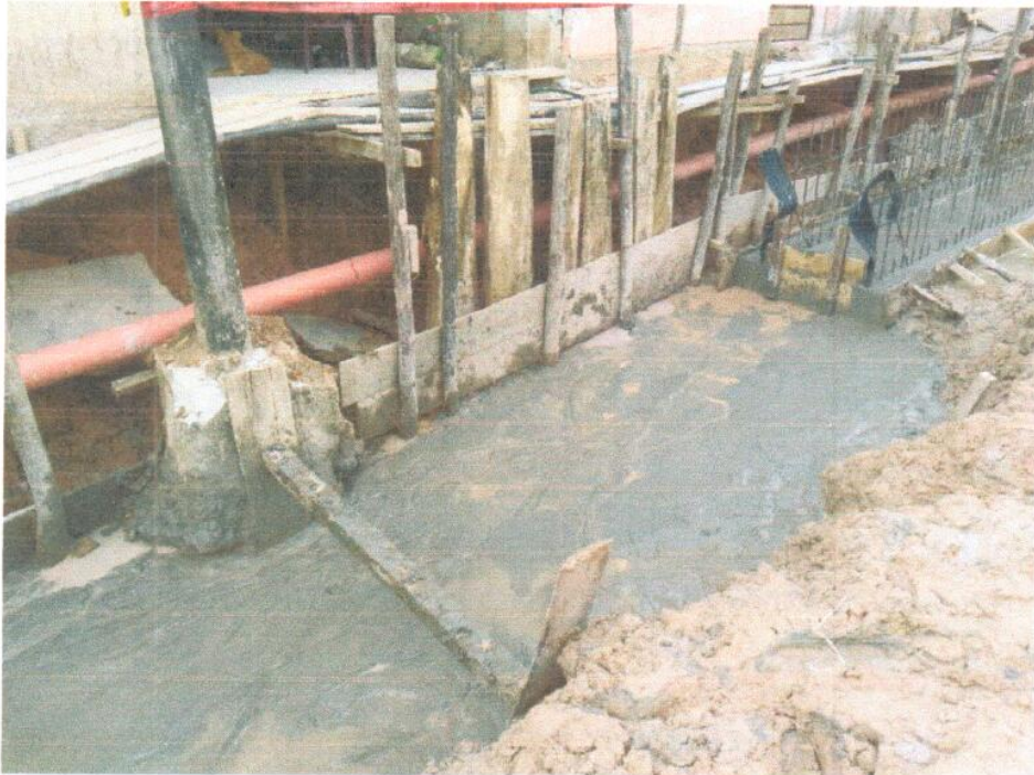
VISTA FOTOGRÁFICA N° 05 – CONFORMACION DE A-2-4 EN PSJ. CASTAÑO
